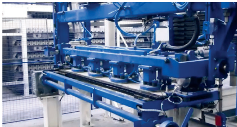
Opération de démoulage
