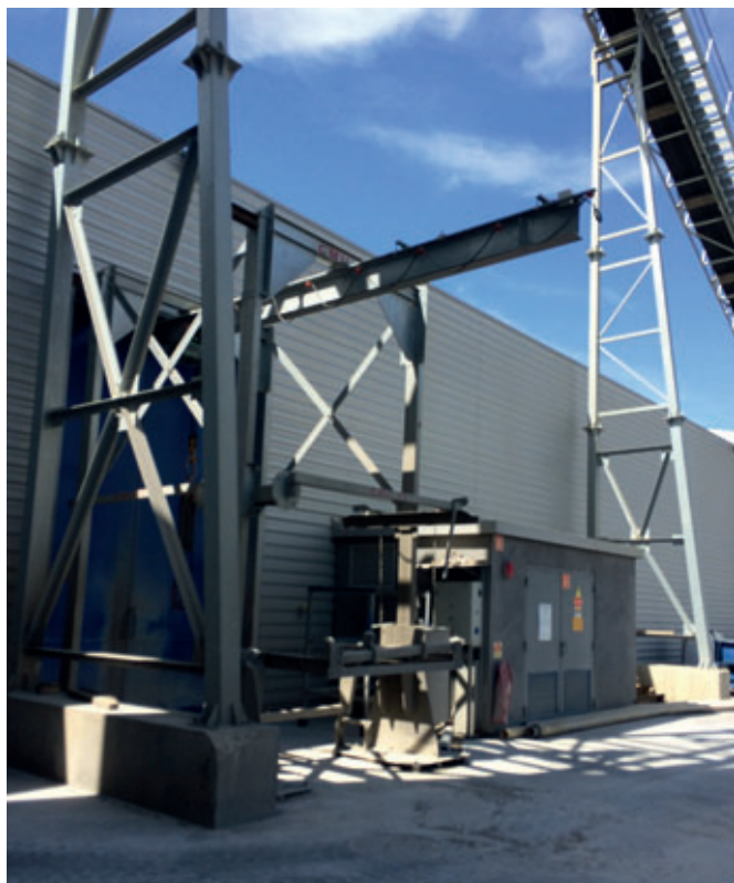
Station de lavage extérieure
