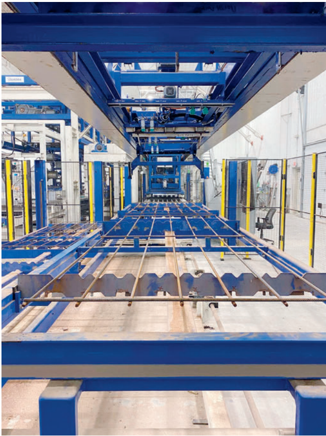
Colocación automática de los elementos de la armadura en el molde vacío
