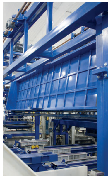
Proceso de desencofrado
