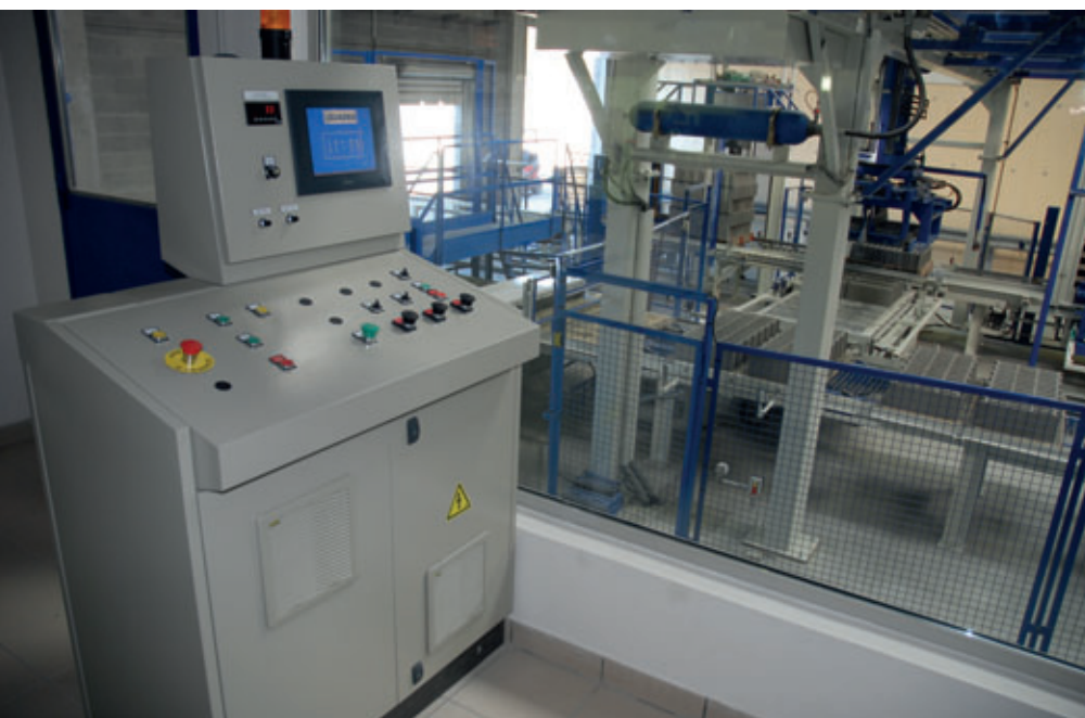
Estação de controle com isolamento acústico com janelas grandes, para permitir uma visão desimpedida sobre a instalação.
