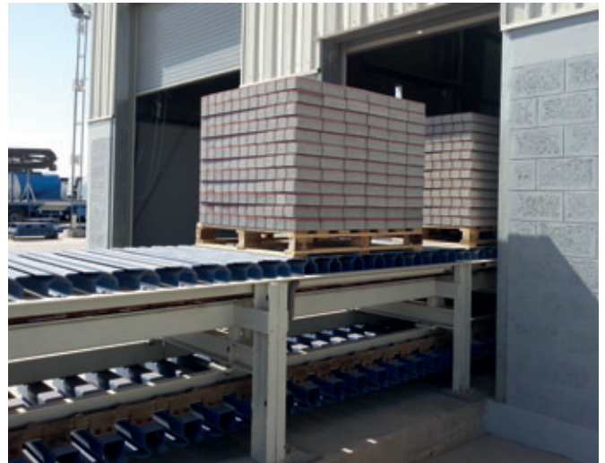
Saída dos produtos de concreto mediante uma esteira de placas
