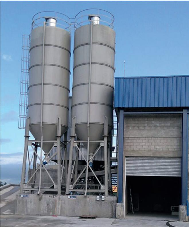
*La instalación dosificadora sobre tierra está completamente galvanizada.*
