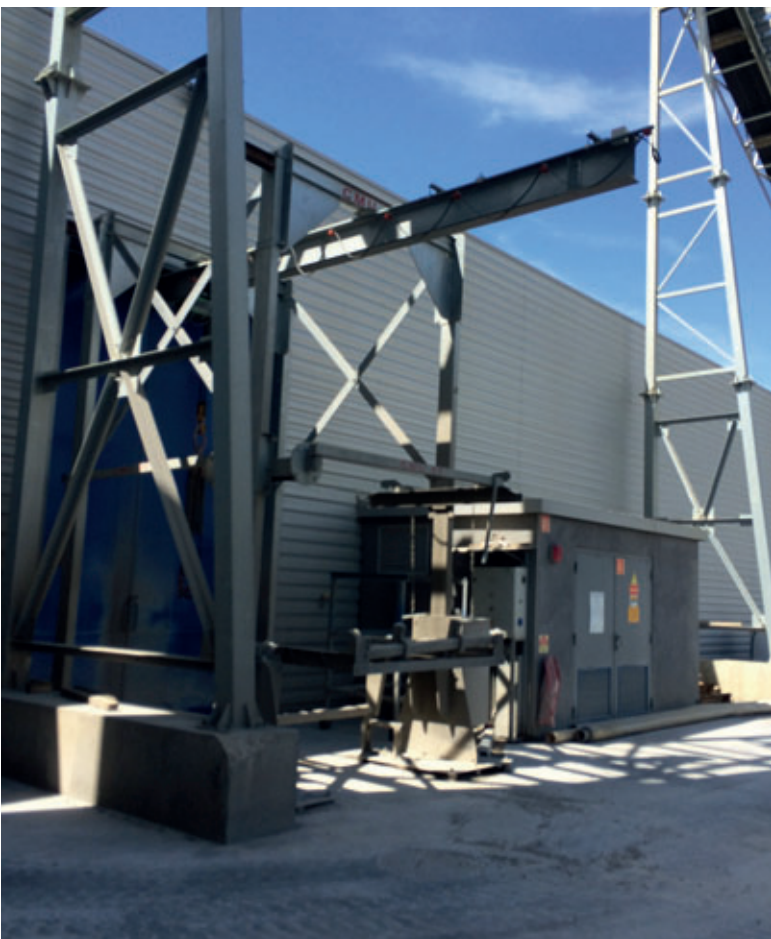
Estación de lavado fuera del edificio
