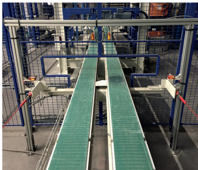
Le poste de palettisation est équipé d'un système de mesure des produits dotés de lasers et de codeur.
