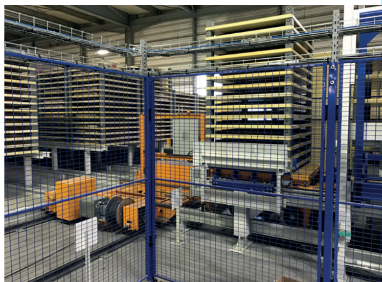
La zone d'étuvage peut recevoir jusqu'à 5200 panneaux.
