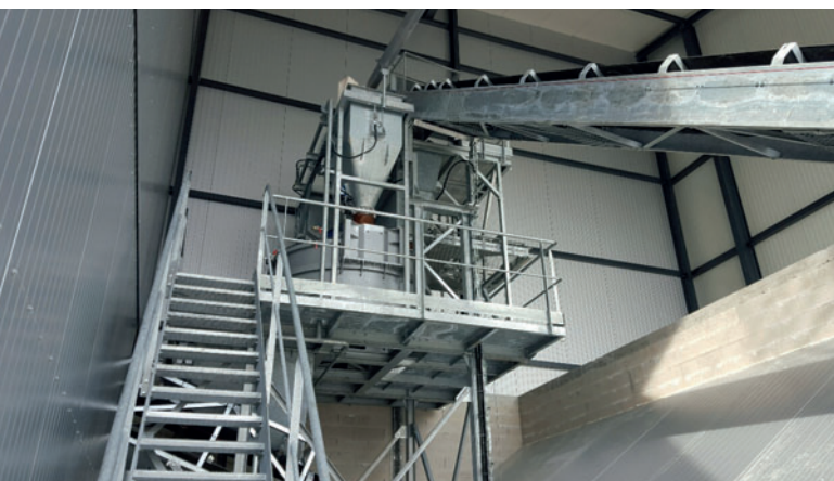
Le chanvre est ensuite acheminé par 2 tapis extracteurs à bandes équipés de chevrons. Les quantités de chanvre, d'eau et de ciment sont mesurées précisément en fonction de la recette de fabrication sélectionnée.
